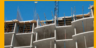
FUNDICIÓN IN-SITU Y PREFABRICADOS DE CONCRETO
